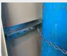
Catene di sicurezza per fissaggio bombole
