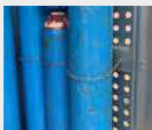
Catene di sicurezza per fissaggio bombole
